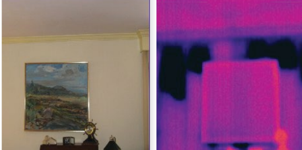
- Vuna u zidovima se slegla tokom vremena.
